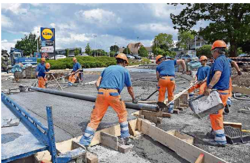
Beim neuen Breiten-Kreisel wird der Deckbelag eingebaut.
